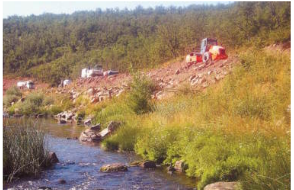
Una de las consecuencias de las obras en la ribera del Arlanza.
